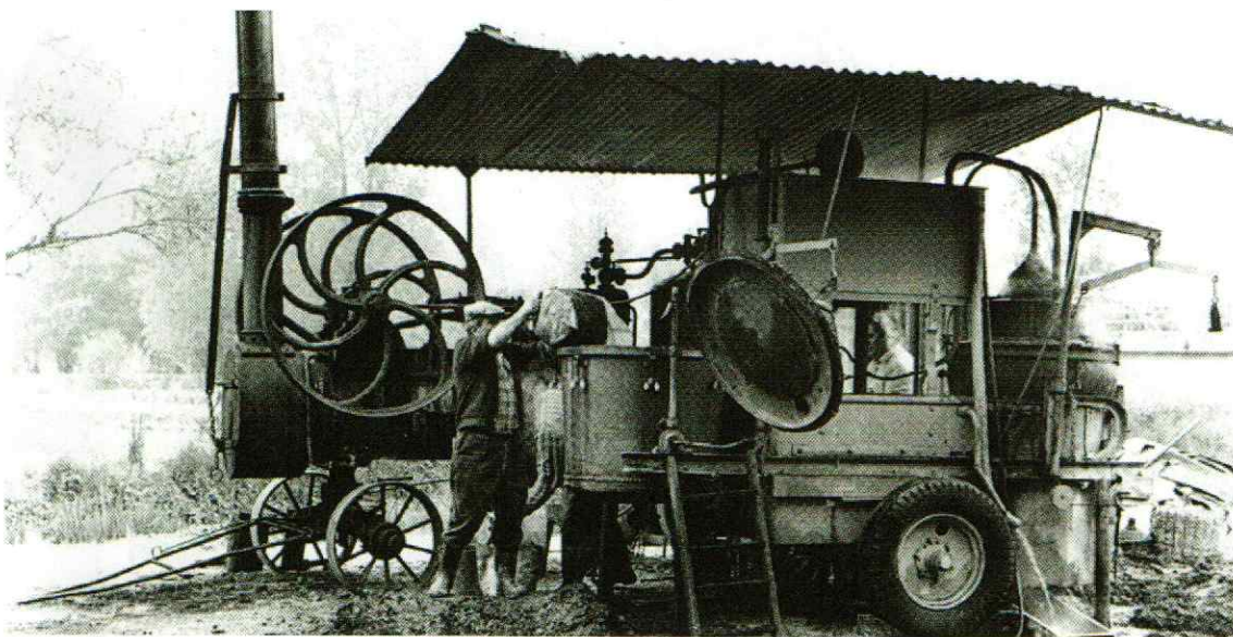
Un distillateur ambulant (appelé aussi « bouilleur de cru »)
